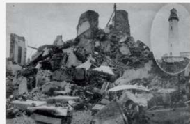
震災で倒壊した野島埼灯台
