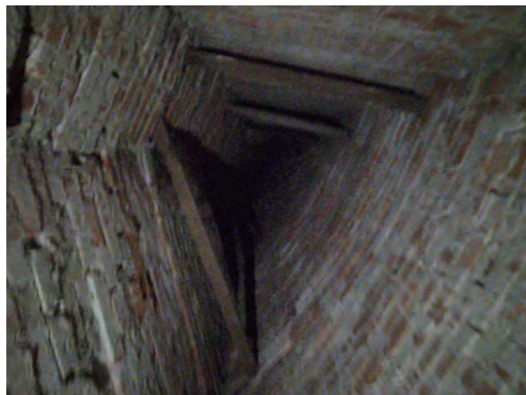
図8:白沙岬灯台の二重円筒構造 19)
